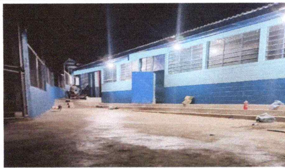
Foto 8: Sustitución de sistema eléctrico en área del corredor y las aulas pendientes de instalación de energía.
