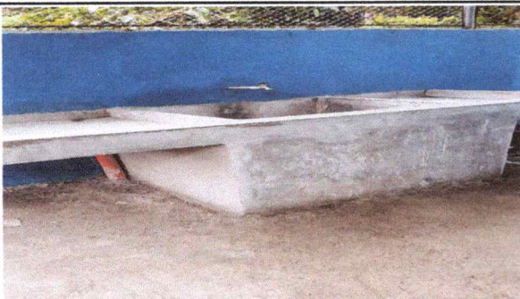
Foto 5: Sustitución lavatrastos por una fabricada en obra azulejado.
