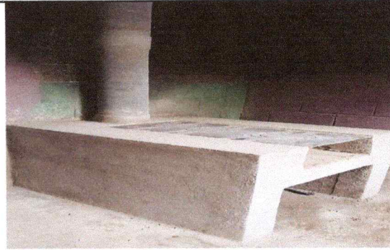
Foto 4: Mejoramiento de cocina con instalación de estufa con ladrillo y chimenea.
