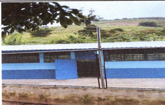
Foto 1: Mejoramiento de techo con láminas troqueladas.
