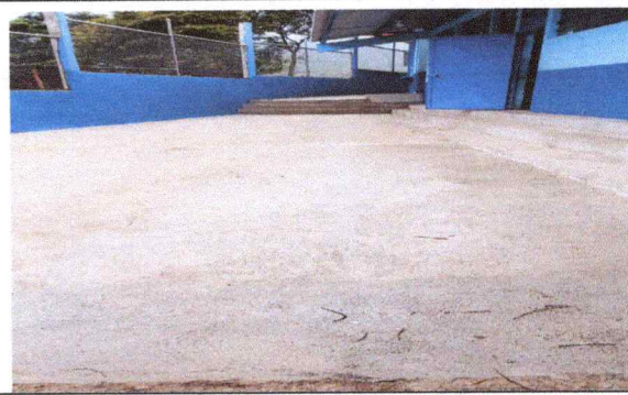
Foto 2: Mejoramiento de piso de concreto del corredor de la escuela y colocacion de caja y tubería de registro de bajada pluvial
