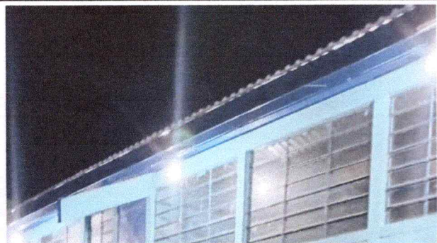
Foto 7: Estado actual del sistema eléctrico en área de corredor.
