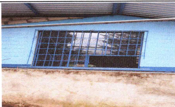
Foto 3: Sustitución de ventana área de cocina a ventana corrediza para servir alimentacion escolar.
